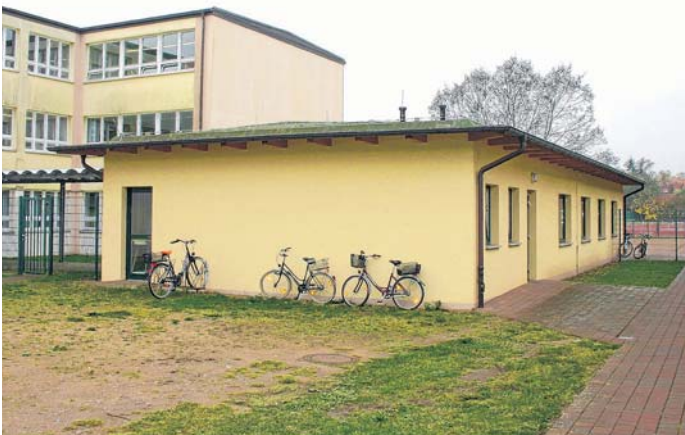
Der Flachbau der Schulspeisung soll, wie vor Jahren ursprünglich schon geplant, nun für den Hort verlängert werden. Die Stadt hofft auf Fördermittel.
